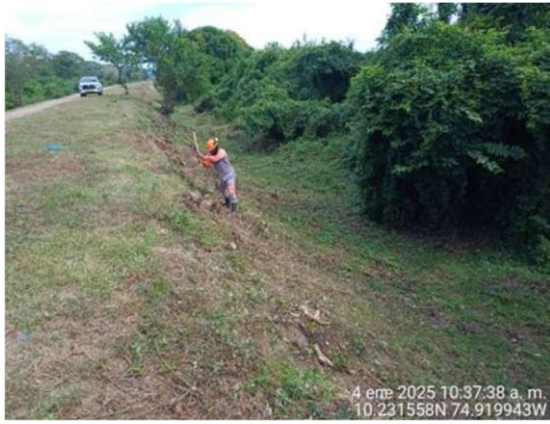
Fotografía 10. Dique protección San Cristóbal
