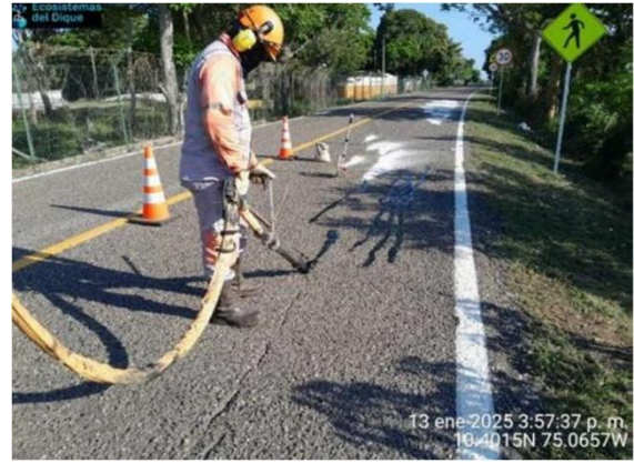
Fotografía 13. Trabajo de selladora de fisuras
