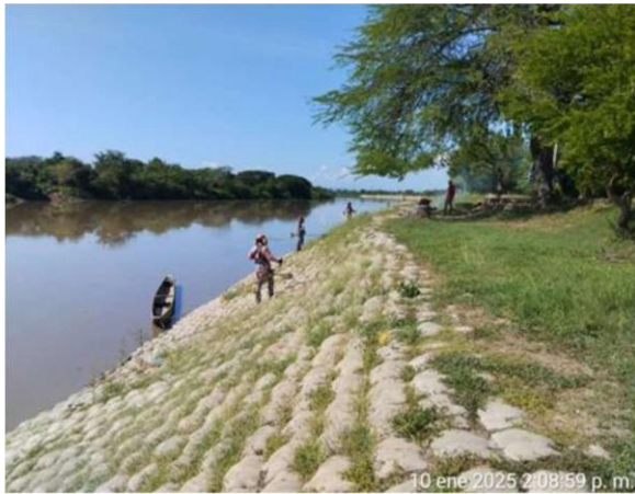
Fotografía 11. Dique protección Santa Lucía.
