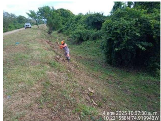
Fotografía 9. Dique protección Calamar
