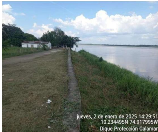
Fotografía 5. Dique protección Calamar
