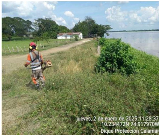
Fotografía 4. Limpieza y rocería
