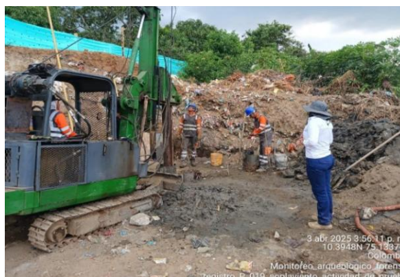
Fotografía 59. Inspección y Monitoreo
