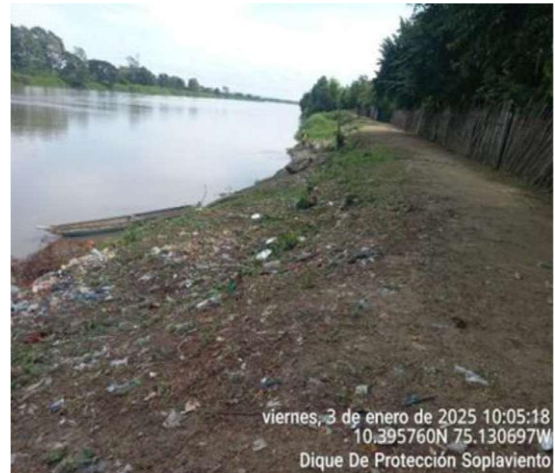
Fotografía 7. Dique protección Soplaviento
