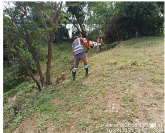
Fotografía 8. Dique protección Calamar
