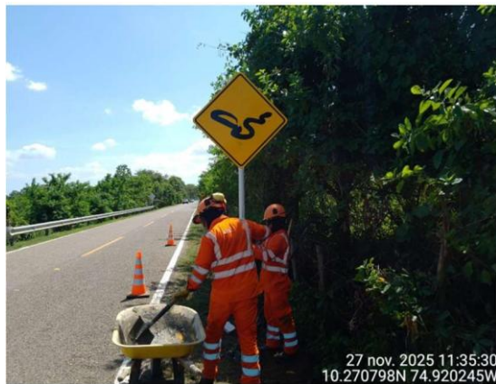
Fotografía 18. Instalación de señales verticales
